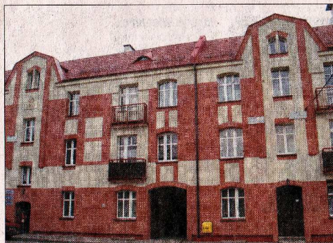
Przy okazji obchodów stulecia ChSM wyremontowano najstarszy w jej zasobach budynek – przy ul. Kordeckiego 5-5a, 7-7a.
