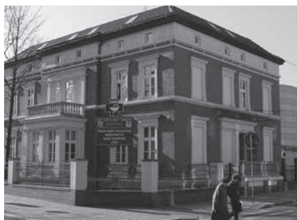
Budynek przy ul. Powstańców 27, część Lecznicy Dzieci i Dorosłych-Szpitala im. I. Mościckiego.
