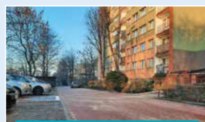
Parking przy ul. Bocznej 6
