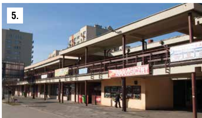
ul. St. Batorego 64 lok. I
