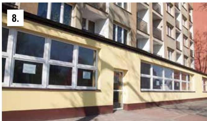
ul. Katowicka 121 lok. I
